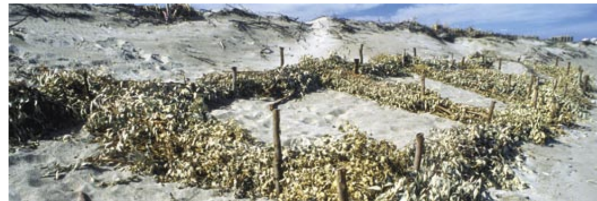
Haces de ramaje utilizadas en la experiencia de 1983. Permeabilizado el murete se colocó en el lado de barlovento un entramado ortogonal de haces de ramaje para favorecer el crecimiento de la duna.
