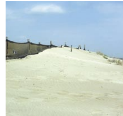
Acumulación de arena como consecuencia de la colocación de mallas de plástico.
