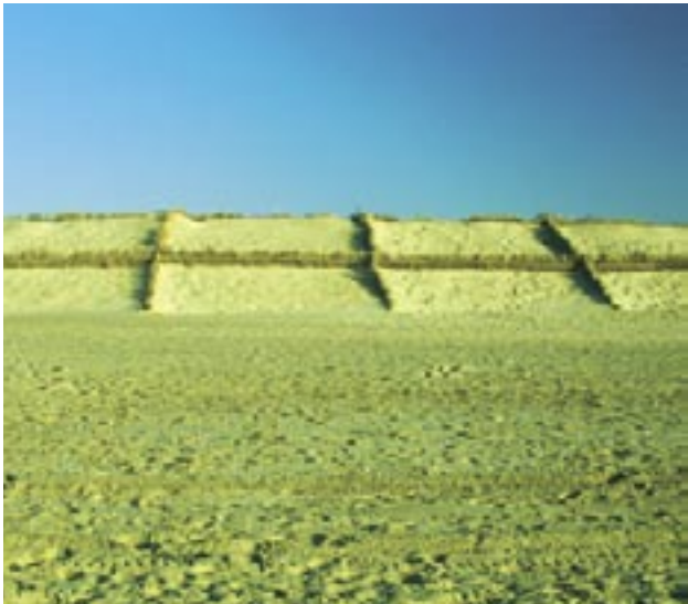
Empalizadas de espartina dispuestas en trama ortogonal.
