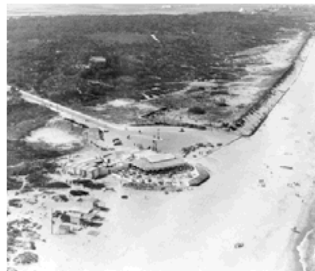
Zona de la playa del Saler antes de la urbanización. Antiguo restaurante “La Dehesa”.
