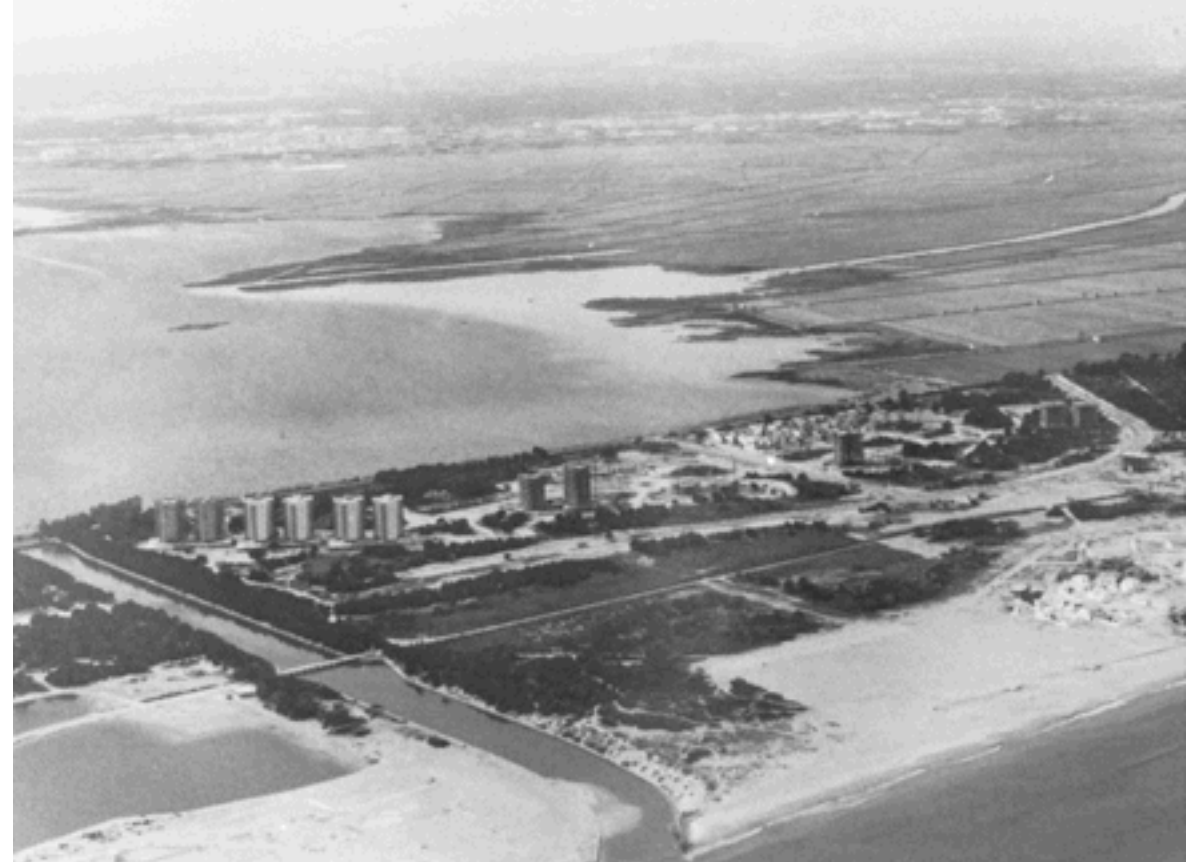
Zona norte de la Gola del Pujol en pleno proceso de urbanización.
