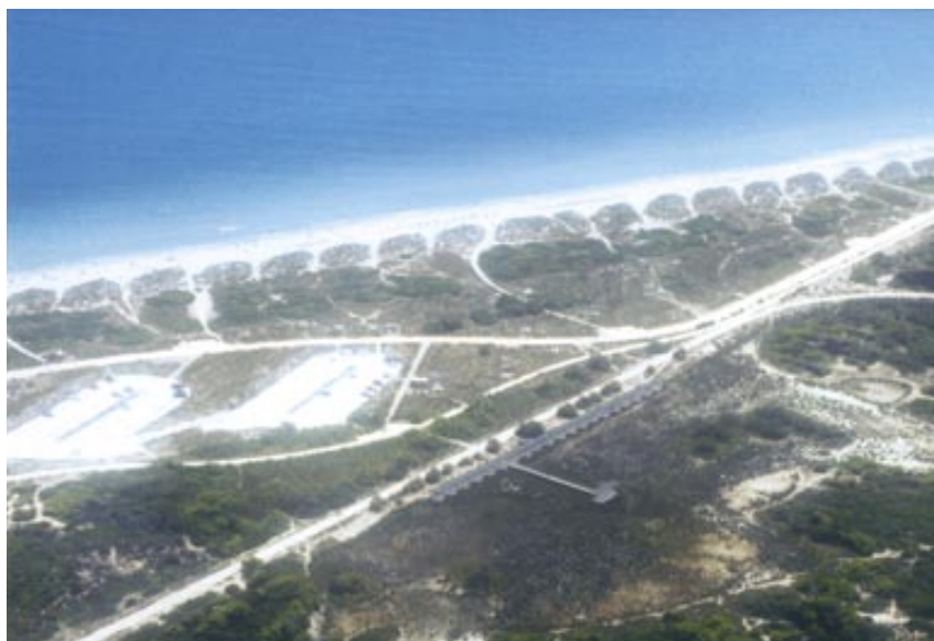
Vista aérea de la mallada regenerada de El Quarter, los nuevos aparcamientos y el primer cordón dunar al fondo.
