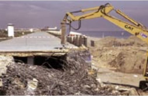
Demolición del paseo marítimo.
