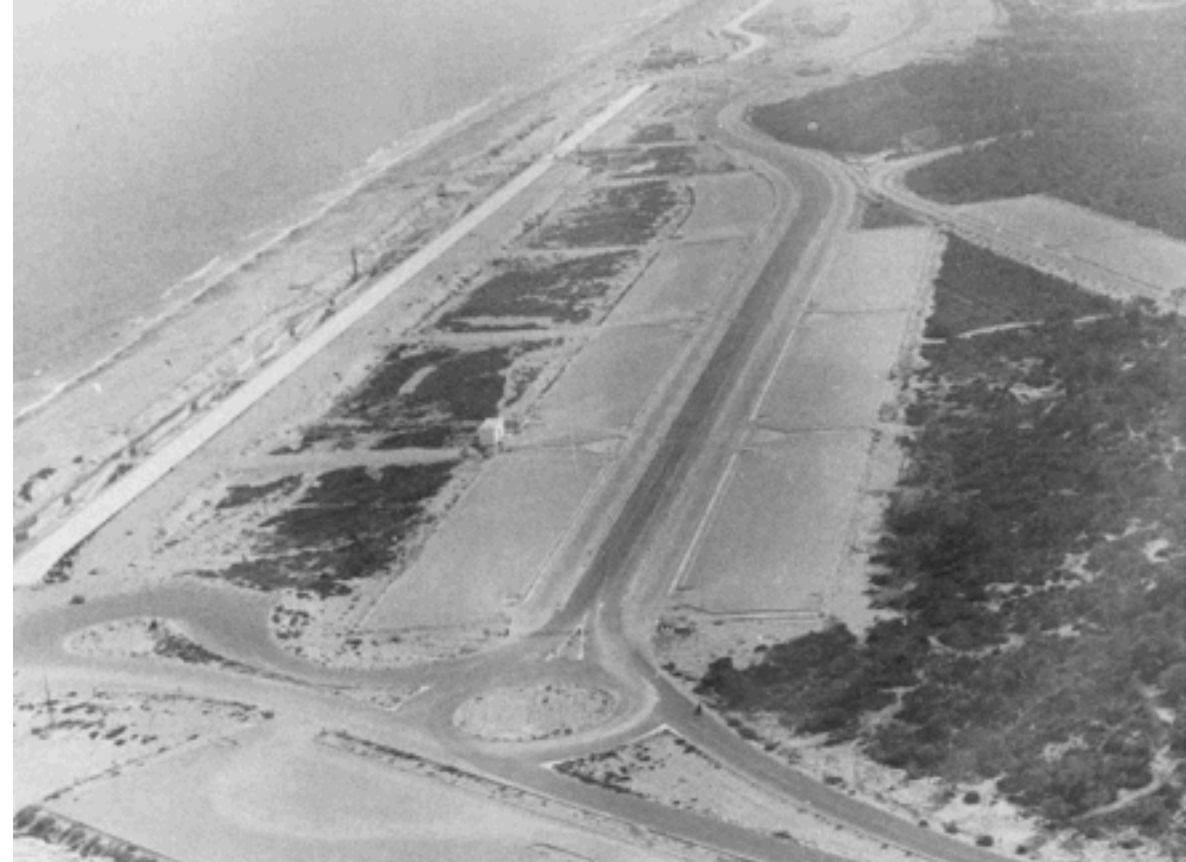
Zona de la Creu durante la urbanización.
