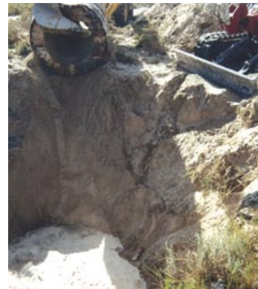
Eliminación de pozos de saneamiento.
