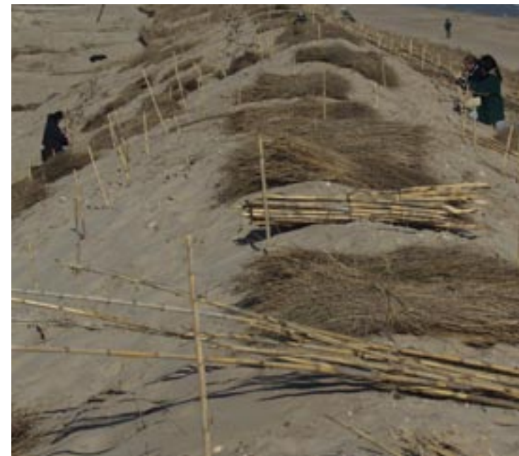
Fijación de la arena con empalizadas.
