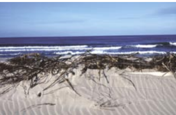
Murete recubierto de haces de restos vegetales. Experiencia de 1982.
