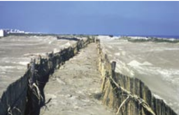
Barreras de cañas utilizadas en la experiencia de 1981.
